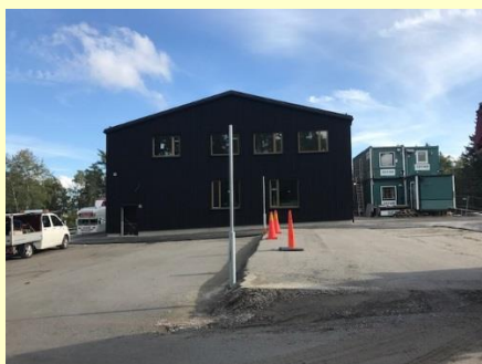
Marken är förberedd för asfaltering
